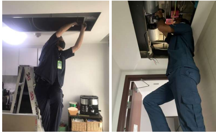
ภาพที่ 3-36 ล้างทำความสะอาดระบบปรับอากาศ
