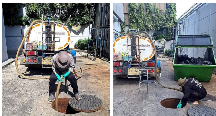
ภาพที่ 3-8 การสูบล้างจากบ่อบำบัดตะกอน
